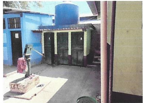
REPARACION Y MANTENIMIENTO DE PUERTAS
