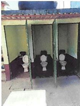
SUSTITUCION DE INODOROS
