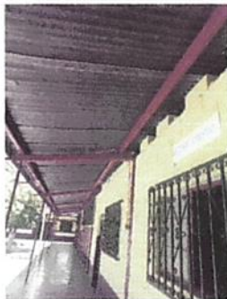
SUSTITUCION DE BALCONES
