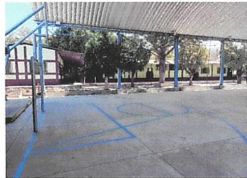
PINTURA MUROS EXTERIORES E INTERIORES
