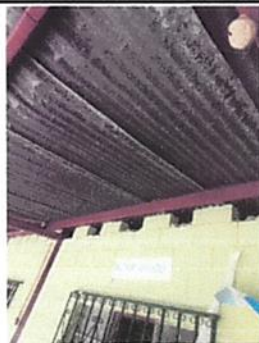
DESINSTALACION Y SUSTITUCION DE LAMINA Y CAPOTE DE LAMINA
